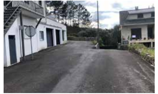
MUST-515 | Pavimentações e Arranjos em Diversas Estradas, Caminhos: 2024
