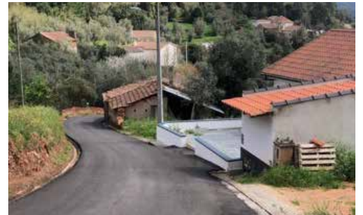
MUST-521 | Pavimentação e arranjos em diversas estradas e caminhos: Rua do Poço, Rua das Pinheiras, Rua da Serrada, Travessa do Portelinho.
