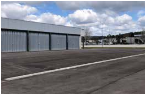
MUST-530 | Pavimentações e Arranjos em Diversas Estradas, Caminhos: 2024/2025
