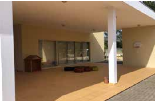
MUST-524 | Conservação e Beneficiação de Instalações: Jardim de Infância Lagoa Parada 2024
