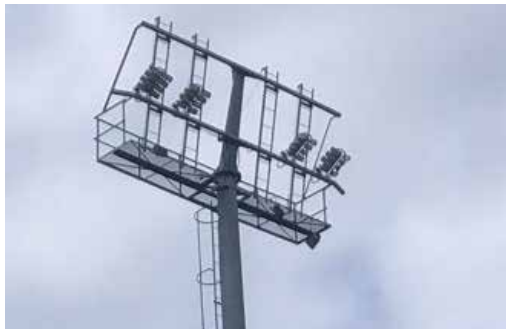
MUST-522 | Parque Desportivo Municipal de Ansião: Instalação Iluminação LED.
