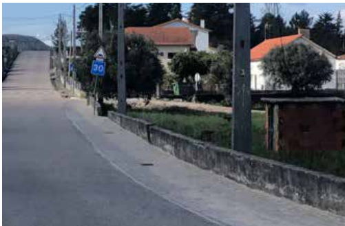
MUST-531 | Ampliação e Manutenção da Rede Pluvial: 2024
