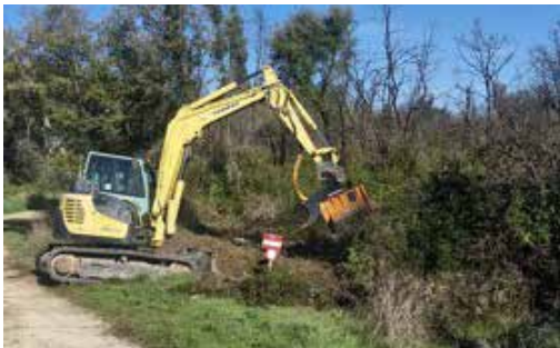
CFST-83 | Intervenções de Estabilização de Emergência: Ações de Reabilitação da Rede Hidrográfica nos Concelhos Afetados pelos Incêndios em 2022
