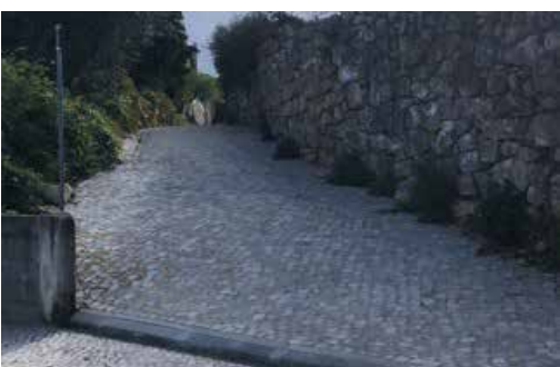
MUST-533 | Pavimentação em Calçada de Diversos Arruamentos: Freguesia de Alvor 2024.
