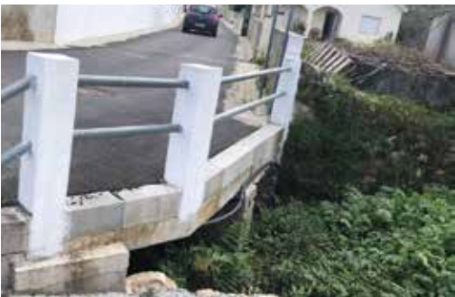
MUST-525 | Obras de Arte e Pontões: 2024
