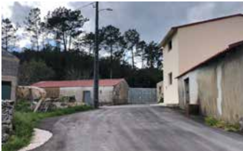
MUST-517 | Pavimentação Lagoa Parada/ Alho/ Castelo (Rua das Barreiras/ Rua do Pedregal) - Santiago
