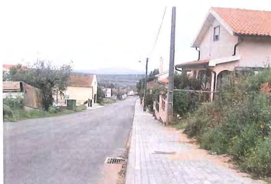
Rede de águas pluviais e Passeio – Casal Santo António - AVELAR
