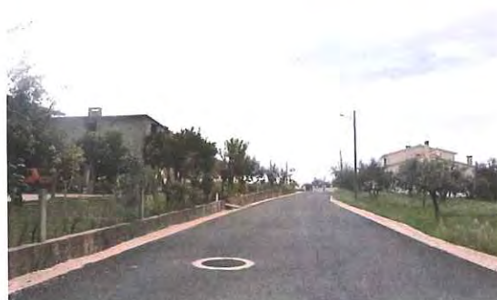
Pavimentação em Rua da Cerca – CHÃO DE COUCE
