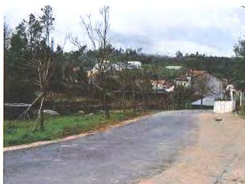
Pavimentação Lagoas / Sarzedela – ANSIÃO
