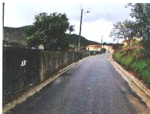
Pavimentação da Rua do Guincho- CHÃO DE COUCE
