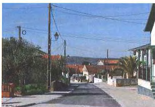
Pavimentação da Rua do Castelo - AVELAR
