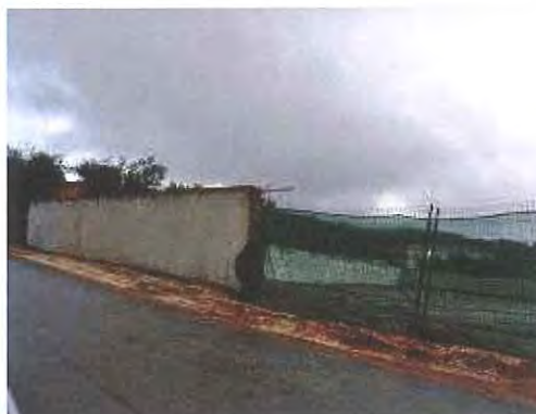
Execução de Muros do Cemitério de Avelar- AVELAR
