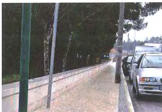
Obras Requalificações Urbanas – Muro Vedação antigo Campo da Mata - ANSIÃO
