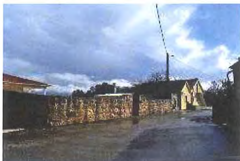
Pavimentação Santiago da Guarda / Casal do Louco – SANTIAGO DA GUARDA
