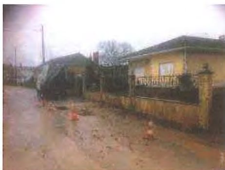
Manutenção e Conservação da Rede de Água: 2015 / 2016
