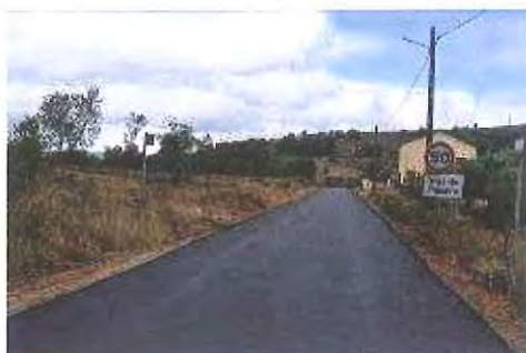
Pavimentação da Estrada Trás de Figueiró / Ateanha - ALVORGE
