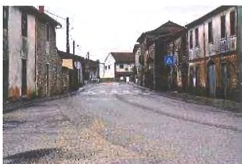
Passeios e Bermas em Junqueira - ALVORGE
