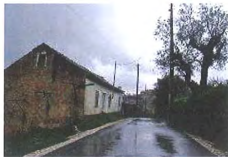
Pavimentação em Vale Aversada 2015 – SANTIAGO DA GUARDA
