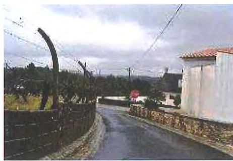
Pavimentação Fonte Santa - Ansião
