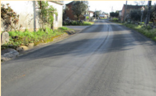
Estrada do Casal - Casal Ant.º Brás, Santiago da Guarda Pavimentação Antiderrapante
