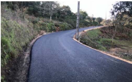
Pavimentação Betuminosa: Freguesia de Alvorger - CM Mata de Cima / Mata de Baixo
