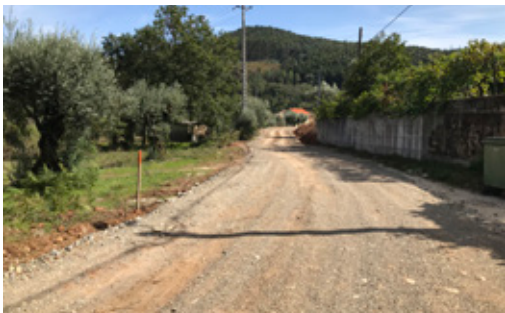
Alargamento da Rua Mata do Furadouro - Chão de Couce
