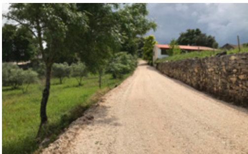
Pavimentação Betuminosa: Freguesia de Ansião - Rua da Bairrada
