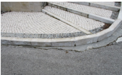
Reparação de lancil e passeio - Avenida Luís Vaz de Camões, Ansião
