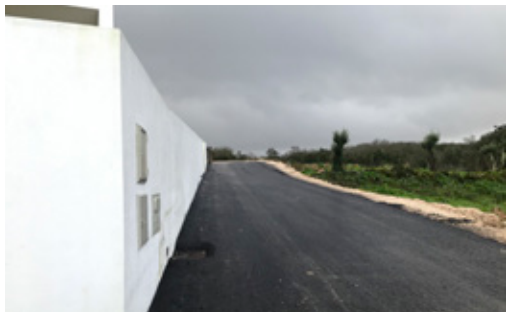
Pavimentação Betuminosa: Freguesia de Alvorge - Largo das Tílias, Bemposta
