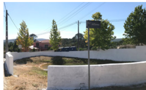
Pintura de muros na lagoa – Lagoa Parada
