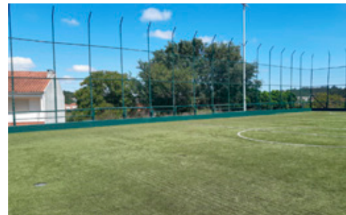
Infraestruturas e Equipamentos: Beneficiação de Polidesportivo de Ansião
