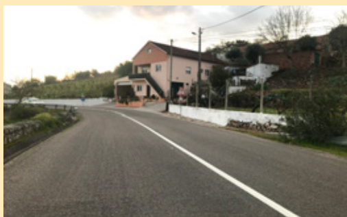
Sinalização Horizontal: CM 558 e M559
