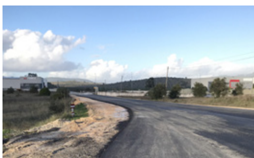
Pavimentação Betuminosa: Freguesia de Chão de Couce - Rua Cinzenta, Parque Empresarial de Camporês
