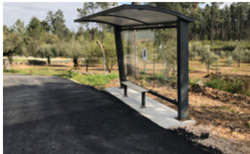
Instalação de novo abrigo de passageiros - Pisuaria, Santiago da Guarda
