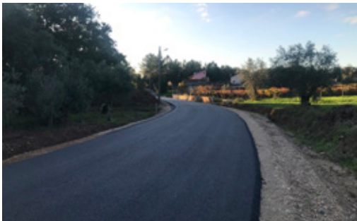
Pavimentação Betuminosa: Freguesia de Avelar - Rua das Lameiras
