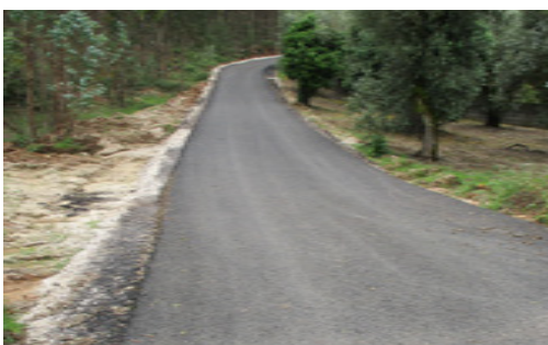
Pavimentação Betuminosa: Freguesia de Santiago da Guarda - Ligação Rua Vale da Vinha à Rua dos Carvalhais, Lagoa Parada
