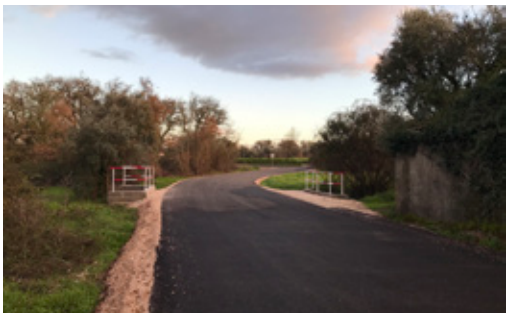
Pavimentação Betuminosa: Freguesia de Chão de Couce - Relvas / CM Cabecinho
