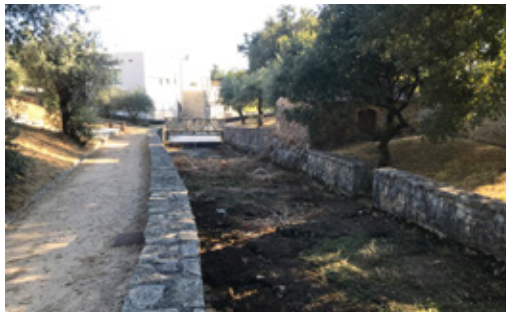
Limpeza do leito do Rio Nabão - Ansião
