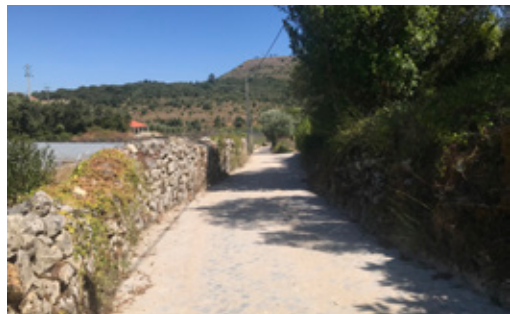
Pavimentação em Calçada: Freguesia de Alvorge - Acesso à Fonte da Ladeia
