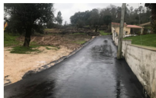
Pavimentação Betuminosa: Freguesia de Alvorge - Rua do Tronco (Travessa)
