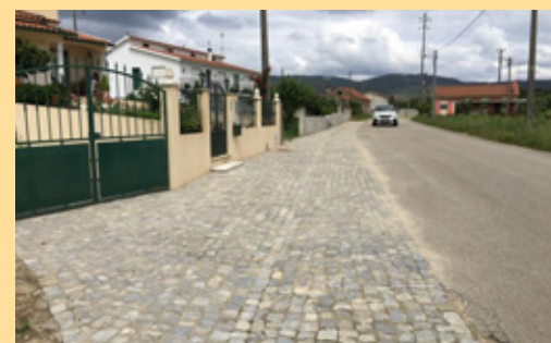
Avelar - Bermas e Valetas em calçada na Rua do Cardal e na Rua do Casalinho
