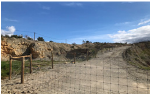
Recuperação Ambiental da Antiga Pedreira da Britaltos: Execução de vedação zona de exploração
