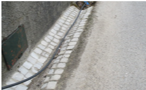
Calçetamento de berma: Freguesia de Santiago da Guarda - Casal do Louco
