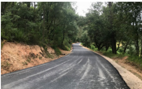
Pavimentação Betuminosa: Freguesia de Santiago da Guarda - Rua do Ribeiro, Vale de Aversada de Cima
