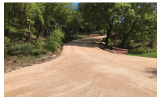
Pavimentação Betuminosa: Freguesia de Pousaflres - Rua de São Sebastião, Albarrol
