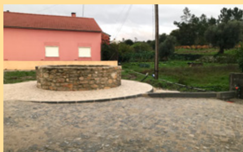
Ansião - Diversas pavimentações em calçada em Sarzedela, Lousal e Casal das Peras
