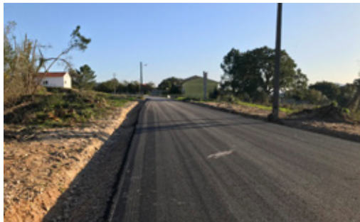
Pavimentação Betuminosa: Freguesia de Avelar - Rua da Saibreira
