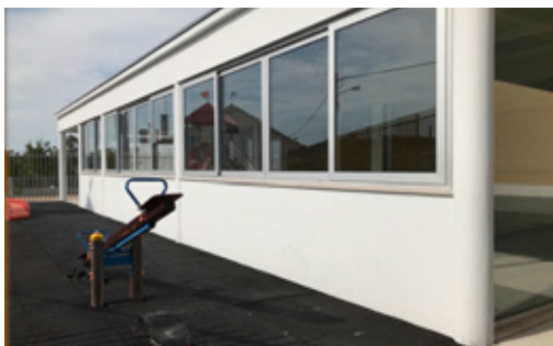
Conservação e Beneficiação de Instalações: Escola Básica n.º1 de Ansião - 2ª fase
