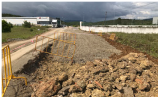
Estabilização do acesso à zona Norte do Parque Empresarial do Camporês - Rua Cinzenta
