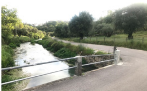
Pavimentação Betuminosa: Freguesia de Santiago da Guarda - Ligação Nogueiros - EN237
