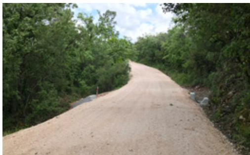
Pavimentação Betuminosa: Freguesia de Ansião - Curcial de São Bento
