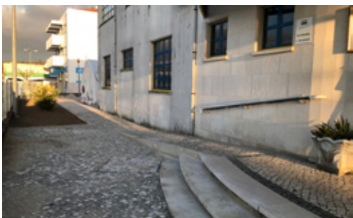
Apoio a Infraestruturas e Equipamentos: Beneficiação do Centro Saúde de Ansião
