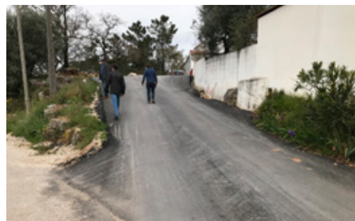
Pavimentação Betuminosa: Freguesia de Alvorge - Rua de S. José, Vale Galego
