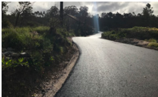
Pavimentação Betuminosa: Freguesia de Ansião - Rua do Carrascoso / Casal das Pêras
