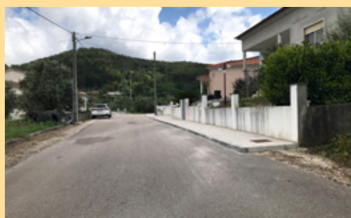
Chão de Couce - Execução de passeios e calçadas em Chão de Couce
