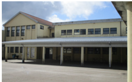
Remoção de Fibrocimento na Escola Básica n.º2 de Avelar
