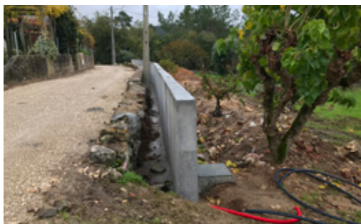
Muros e Outras Estruturas: Freguesia de Pousaflôres
