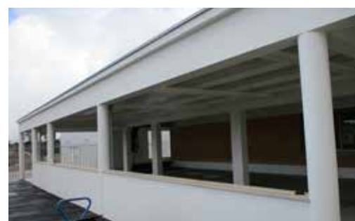
Escola Básica N.º 1 de Ansião Beneficiação das Instalações
