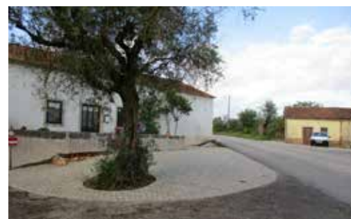
Pavimentação em Calçada de Diversos Arruamentos Moita Santa de Baixo, Rua da Quinta
