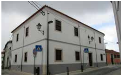
Edifício da Antiga Cadeia Obras de Beneficiação
