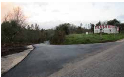
Pavimentações e Arranjos em Diversas Estradas e Caminhos - São Vicente a Pinheiro
