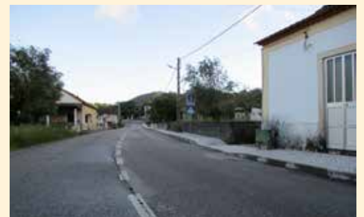
Execução de passeios na Rua Padre António Lopes, em Pousaflres
