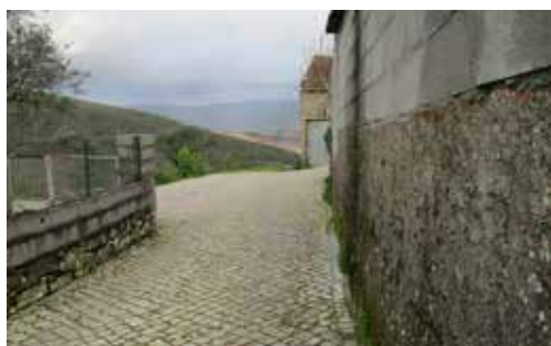
Pavimentação em Calçada de Diversos Arruamentos Ateanha, Rua do Celeiro
