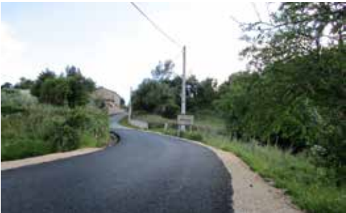
Pavimentação do acesso à Fonte da Ladeia
