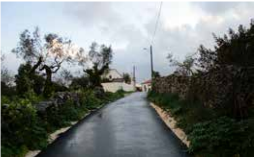
Pavimentações diversas da Freguesia de Alvorde Outeiro, Rua da Relva
