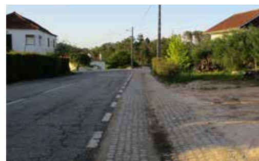
Pavimentação em Calçada de bermas e valetas Cavadas, Estrada dos Peregrinos
