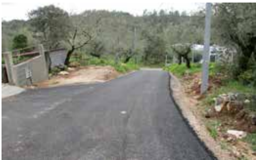
Pavimentações e Arranjos em Diversas Estradas e Caminhos - Travessa da Rua da Zambuja
