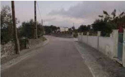
Calçamento Bermas e Valetas Brejo – Netos (Ansião) Bate Água / Areosa
