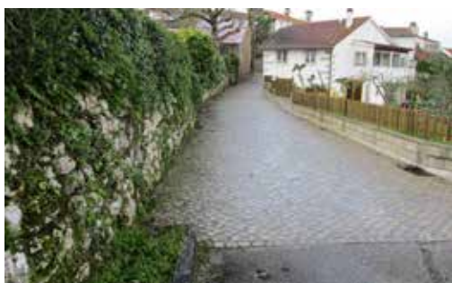
Pavimentação em Calçada de Diversos Arruamentos Alvorge, Rua do Areal
