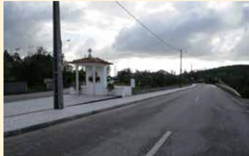
Execução de Passeios na Rua Prof. Adelino Godinho, em Alvorge
