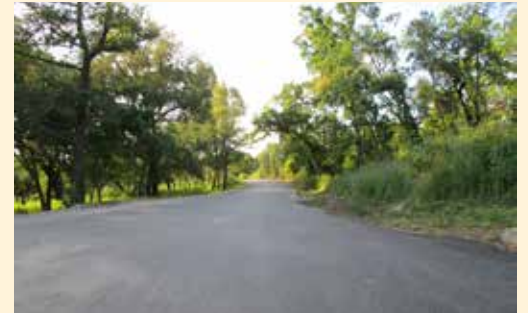
Pavimentação na Rua Serradinhos da Ladeira, em Chão de Couce
