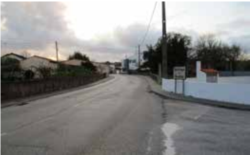
Construção de Passeios em Santiago da Guarda Rua do Arieiro
