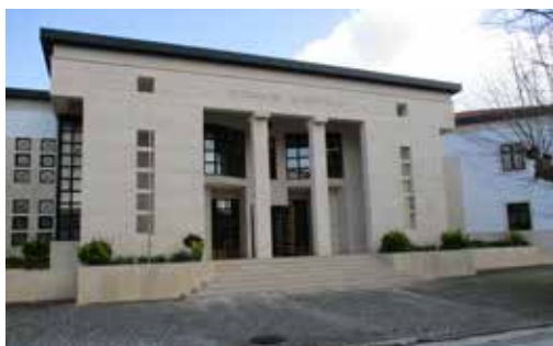
Palácio da Justiça Obras de Beneficiação - Exterior
