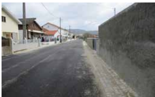
Pavimentações Freguesia de Chão de Couce Alargamento e Beneficiação da Rua do Matinho
