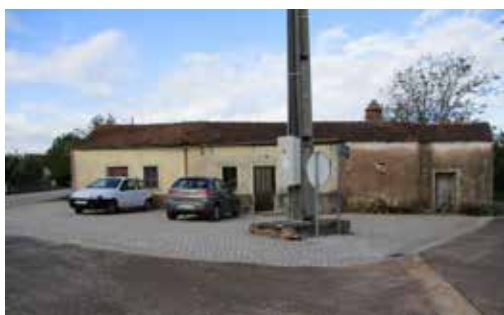
Pavimentação em Calçada de Diversos Arruamentos Moita Santa de Baixo, Rua do Barreiro
