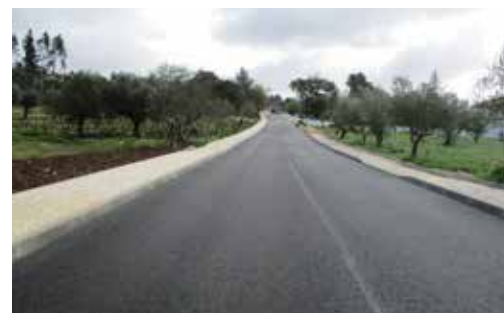
Pavimentações Freguesia de Chão de Couce Beneficiação Av. Mário Furtado dos Santos
