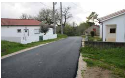
Pavimentações e Arranjos em Diversas Estradas e Caminhos - Travessa de Santana
