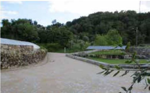
Calçamento do acesso à Fonte da Ladeia
