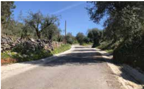
Calçamentos na Freguesia de Ansião Rua da Escola (Lagarteira)
