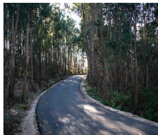
Pavimentação da Rua da Carvalho, Soucide - Santiago da Guarda
