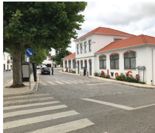
Pavimentação em Calçada - Alvorge
