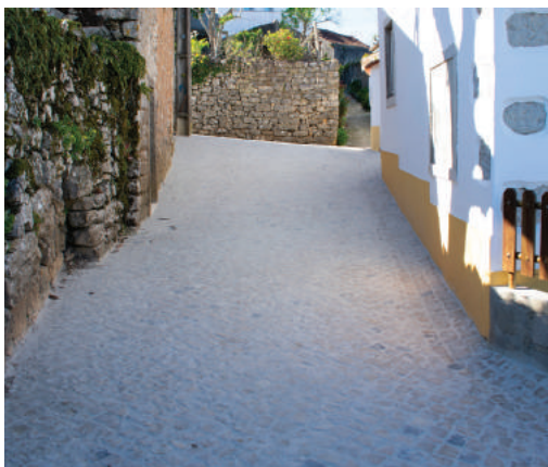
Pavimentação em Calçada de Diversos Arruamentos
