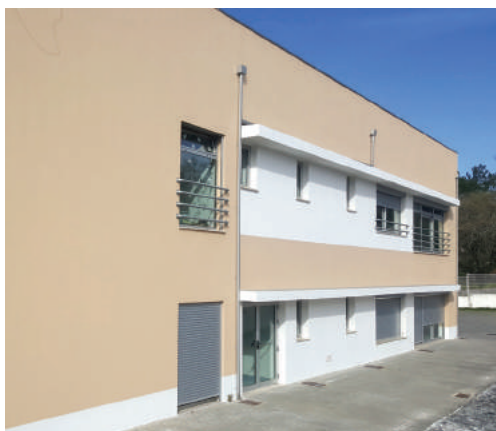
Reabilitação da EBI de Santiago da Guarda
