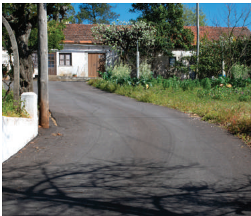
Pavimentação e arranjos em diversas estradas e caminhos
