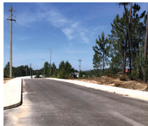
Pavimentação e Passeios na Rua do Sol, Pinheirais - Ansião
