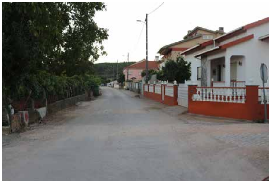
Substituição rede água Rua do Matinho - Avelar 26.500,00 Euros
