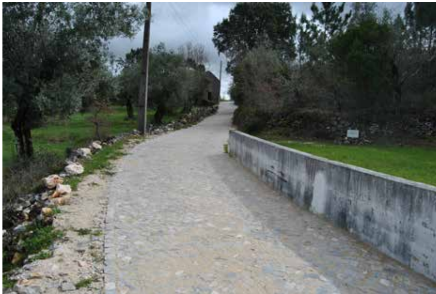
Pavimentação em Calçada em Vale da Vide - Pousaflores 10.377,40 Euros
