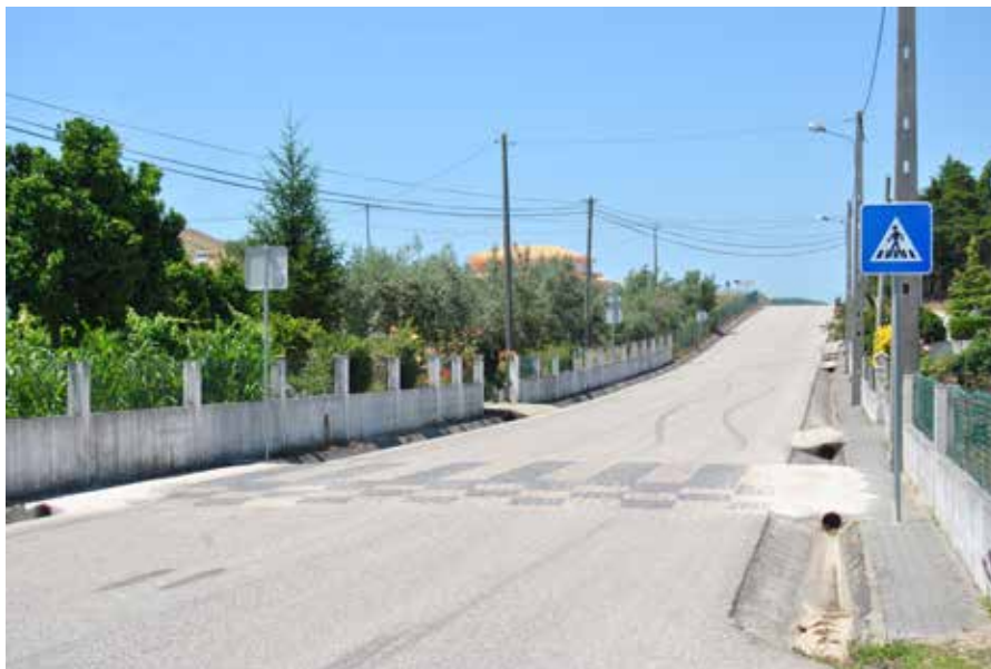
Passadeiras e Lombas em Ribeira de Alcamouque - Alvorge 5.712,34 Euros
