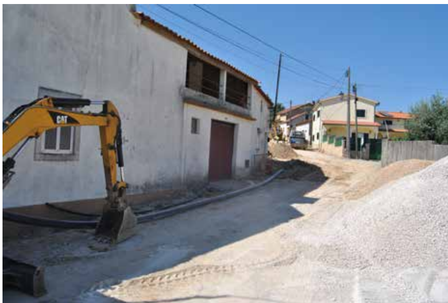
Pavimentação da rua Alfredo Manso à Av. 25 Abril - Avelar 52.470,00 Euros
