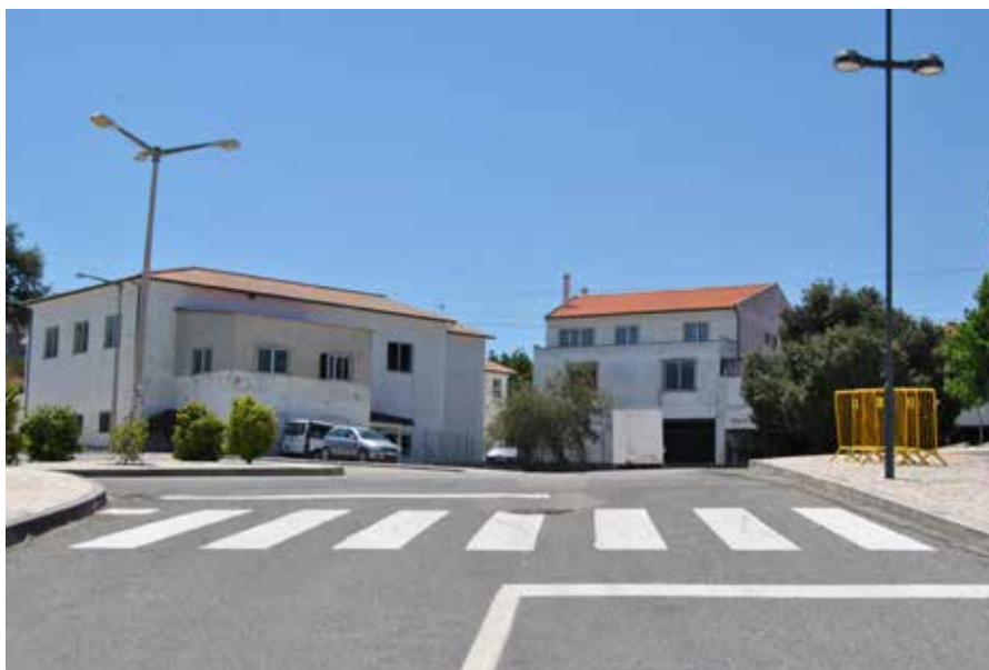
Manutenção de Sinalização Horizontal - Santiago da Guarda 12.142,46 Euros
