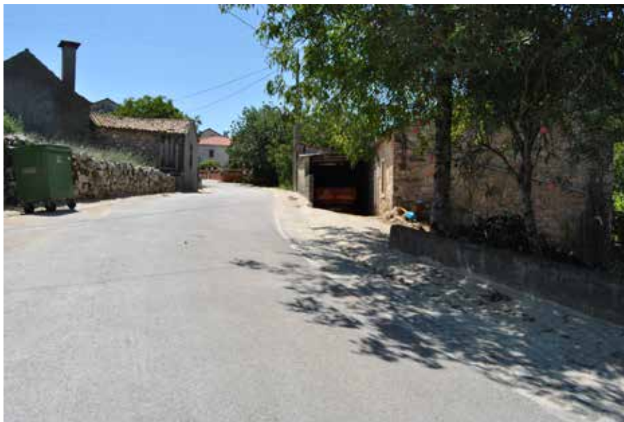
Diversas pavimentações em calçada 17.752,88 Euros
