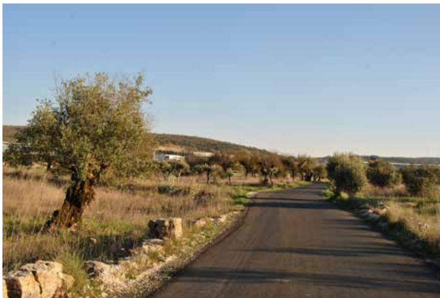
Pavimentação Cabeça Redonda_Camporês - Chão de Couce 30.033,00 Euros
