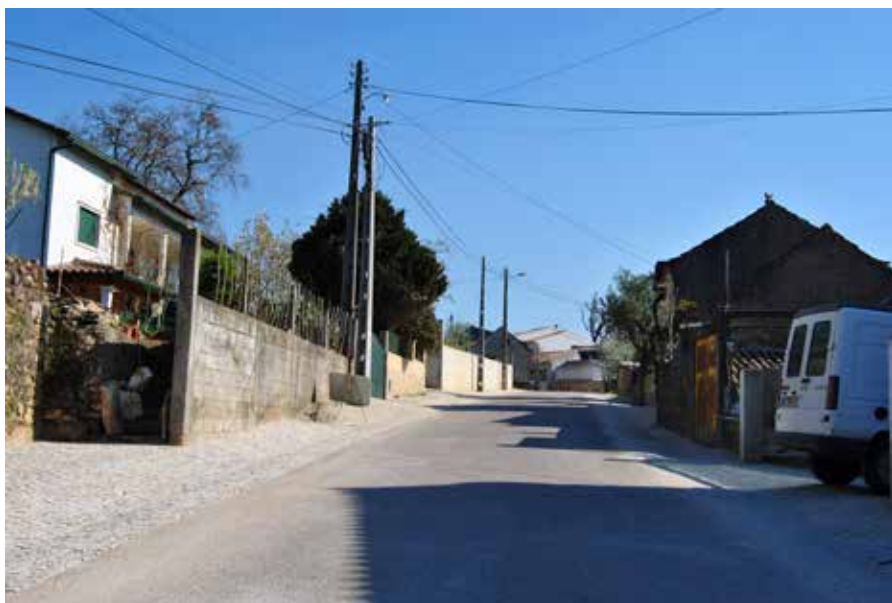
Construção de bermas em Mogadouro - Santiago da Guarda 68.833,43 Euros
