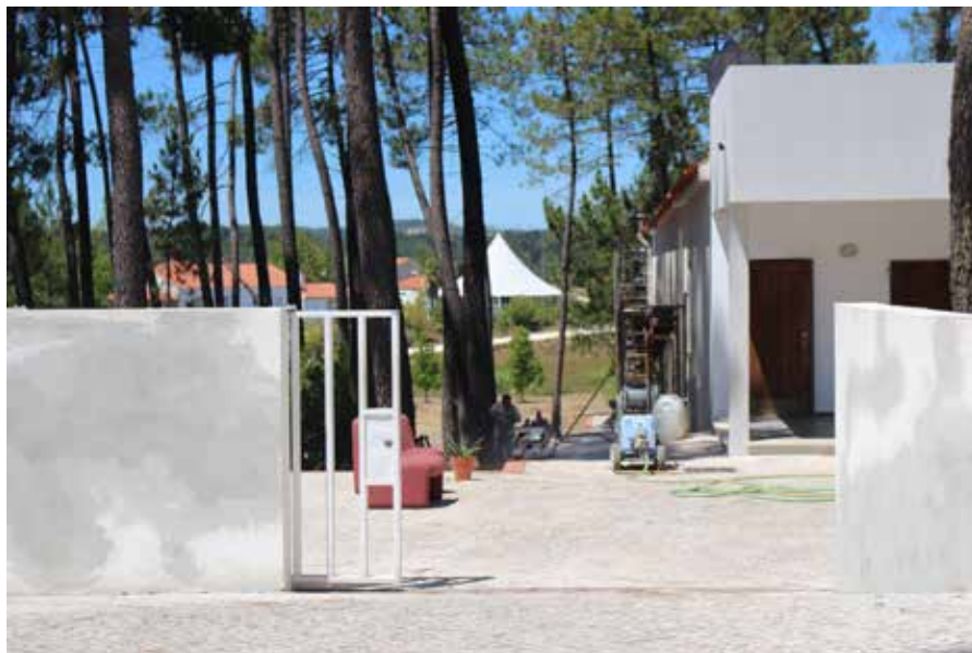
Pintura Exterior da Casa da Amizade e Muros 14.000,00 Euros
