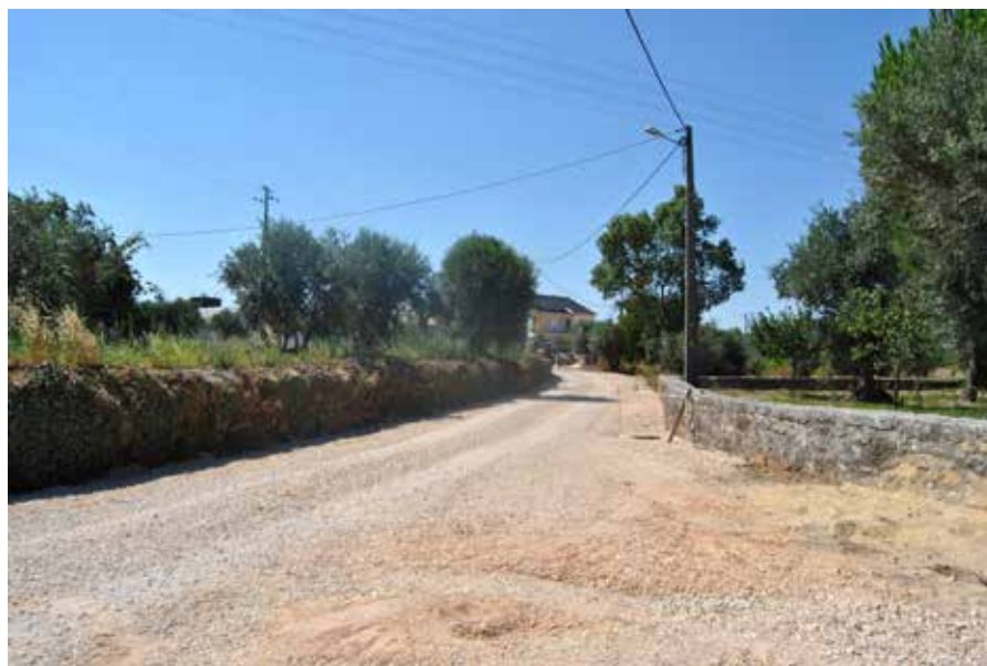
Pavimentação Estrada de Vila Pouca Pedra do Ouro (em curso) - Chão de Couce - 104.174,56 Euros
