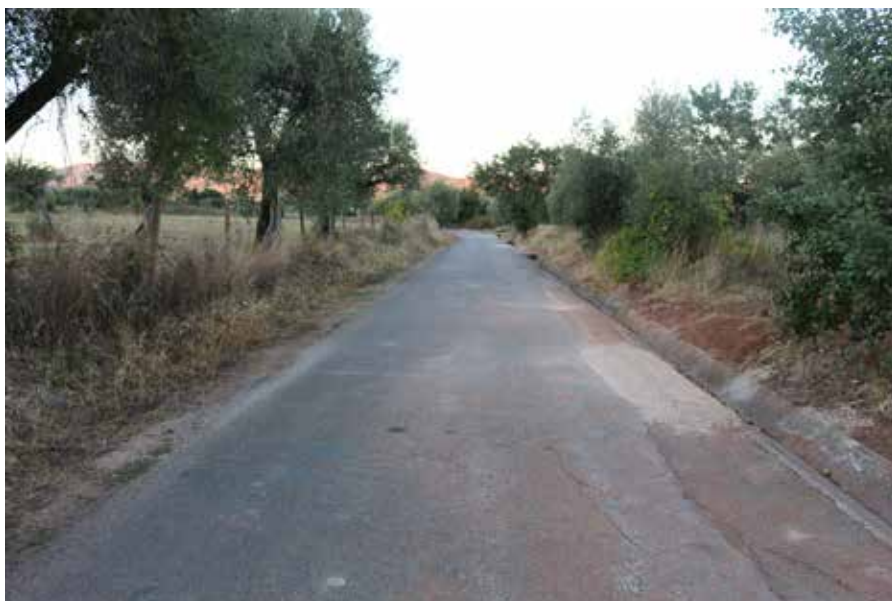
Substituição rede água Rua da Amieira - Chão de Couce 22.500,00 Euros
