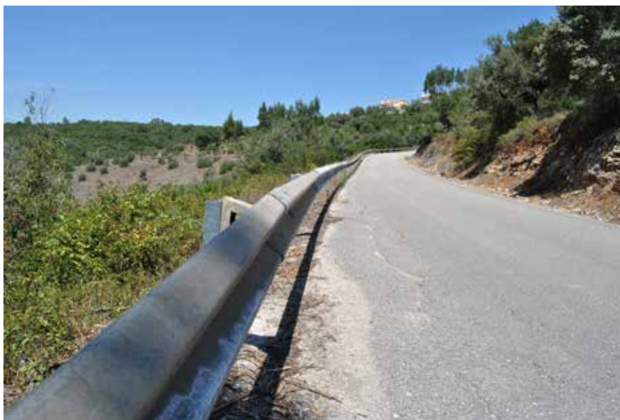
Instalação de rails metálicos em Outeiro - Alvorge 9.994,74 Euros
