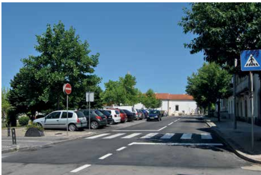
Pavimentação e Arranjos em diversas estradas e caminhos 39.950€
