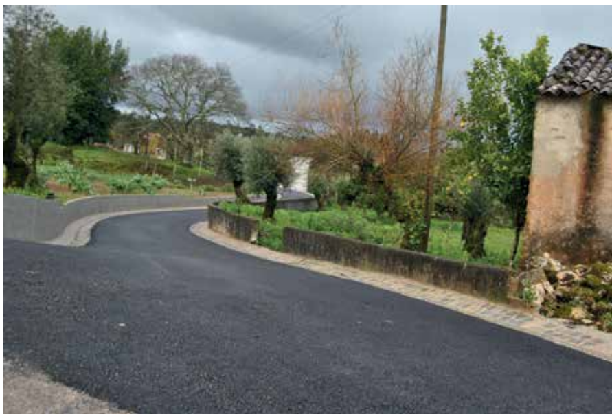
Pavimentação em Charneca do Pessegueiro- Pousaflores 19.650 €
