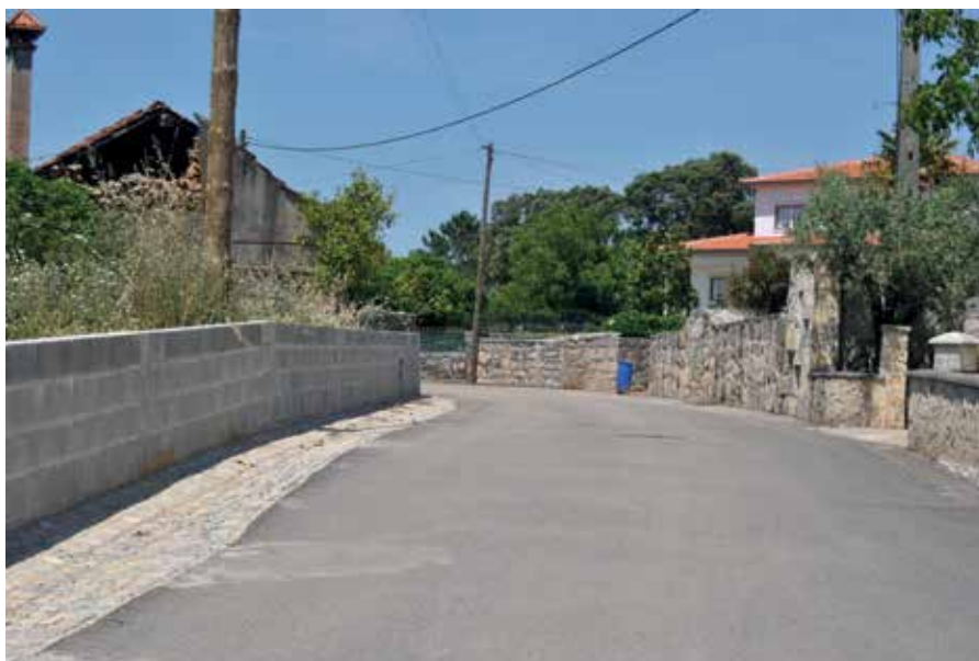
Pavimentação Casal do Louco - Santiago da Guarda 59.550 €
