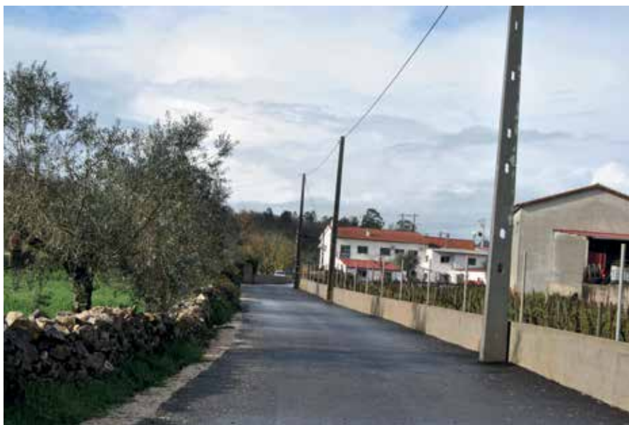
Pavimentação de Fonte-Carvalho a Figueiras de São João- Ansião 39.950 €
