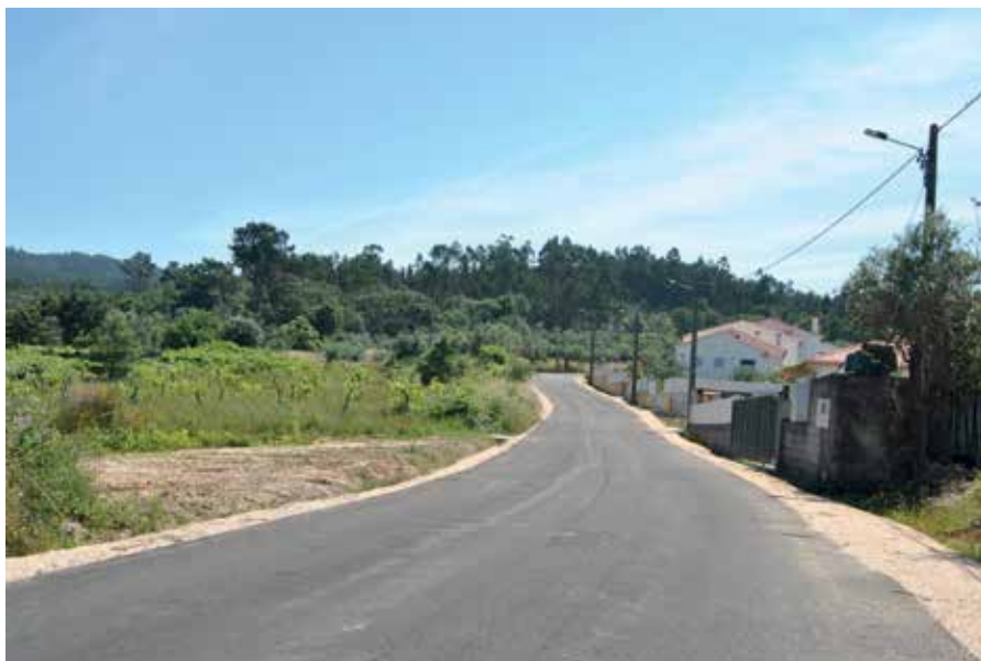
Pavimentação na Rua Maestro Mário Rosa e Travessa do Fonsil-Avelar - 53.000 €
