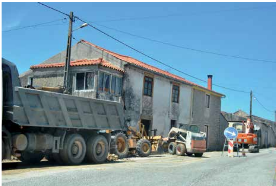
Execução de Passeios e Bermas em Junqueira 68 356,75 €
