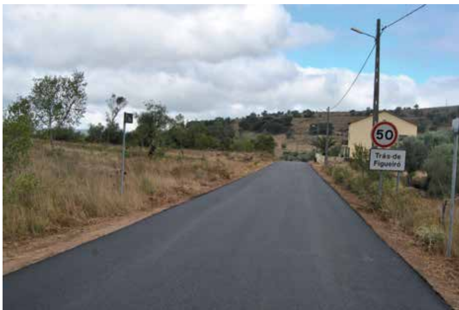
Pavimentação da Estrada Trás de Figueiró - Ateanha 124.020 €
