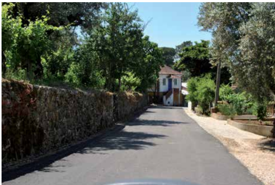
Pavimentação da Rua da Carrasqueira- Mogadouro 68 407,10 €
