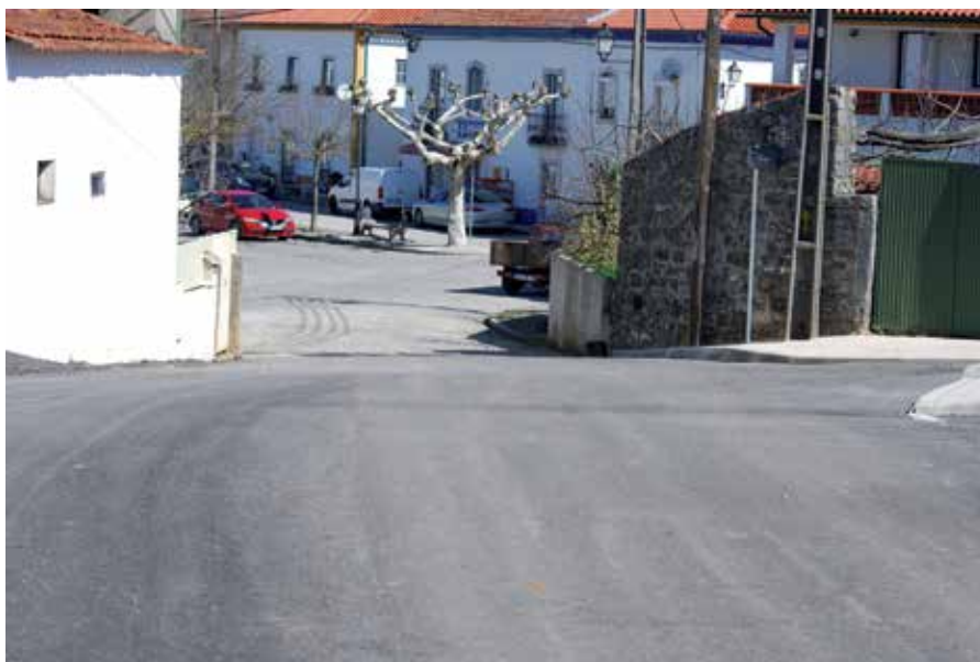
Pavimentação rua do Lagar - Alvorge 14 580,30 €
