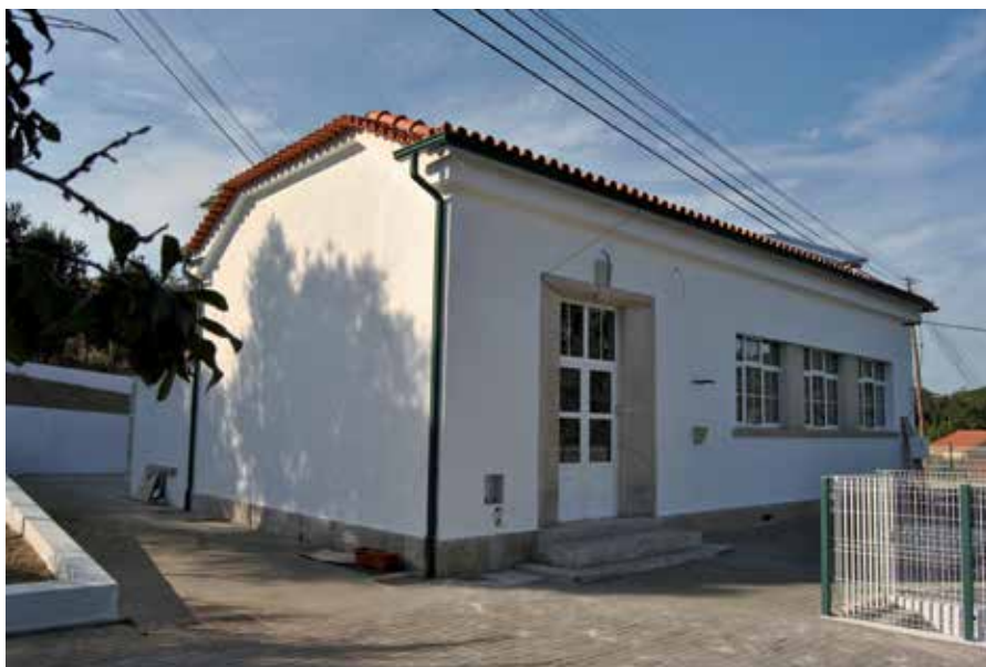
Adaptação de Escolas Desactivadas - Escola de Marquinho 56 950,08 €
