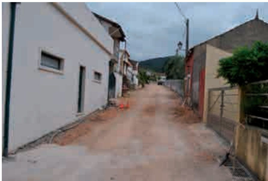
Pavimentação e Requalificação da Rede de Água da Rua do Castelo (Avelar) -144.100€
