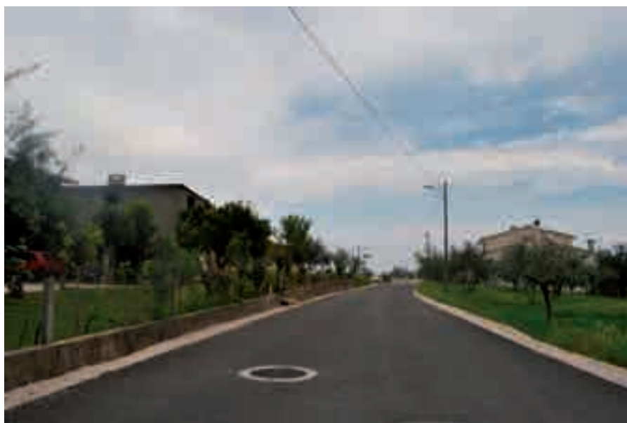
Pavimentação da Rua da Cerca (Chão de Couce) - 69.000€
