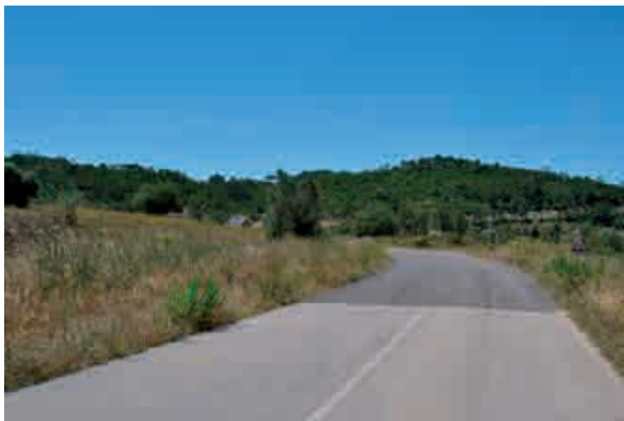
Conservação de Diversas Estradas e Caminhos no Concelho Pavimentação Antiderrapante - 34.400€
