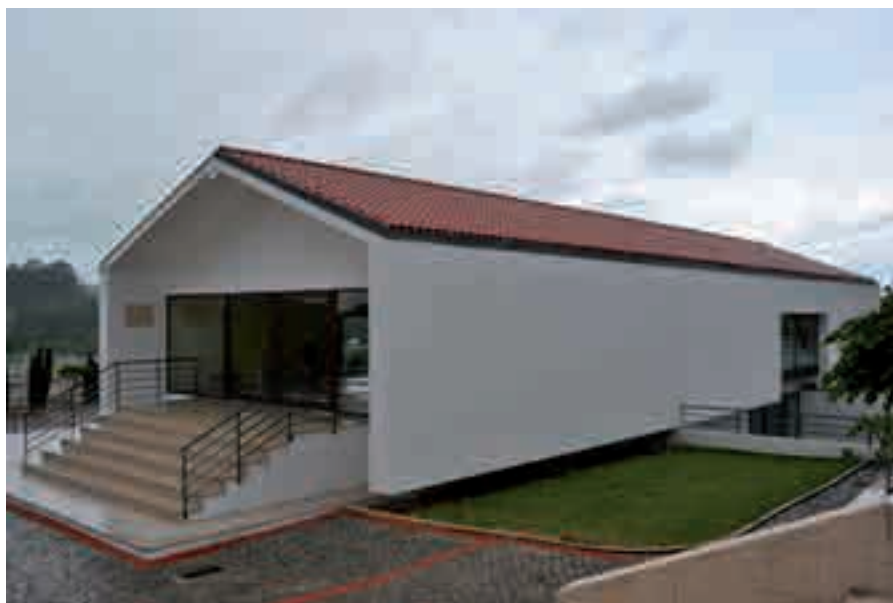
Beneficiação da cobertura e pintura exterior do Mercado Polivalente de Alvorge - 16.000€
