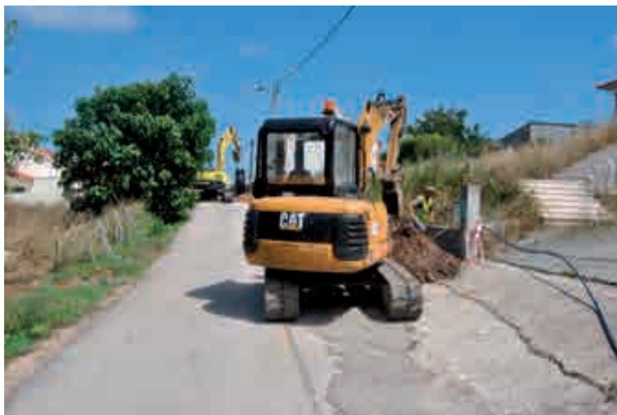
Pavimentação e Requalificação da Rede de Água na Rua da Mó (Chão de Couce) - 52.450€
