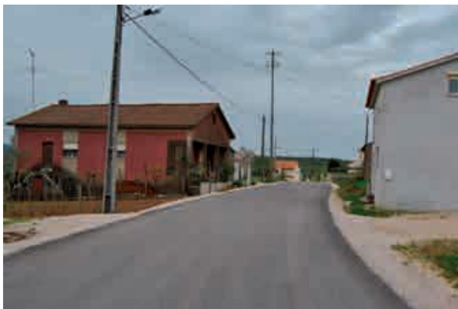
Pavimentação e Requalificação da Rede de Águas na Rua do Cardal (Avelar) - 89.500€
