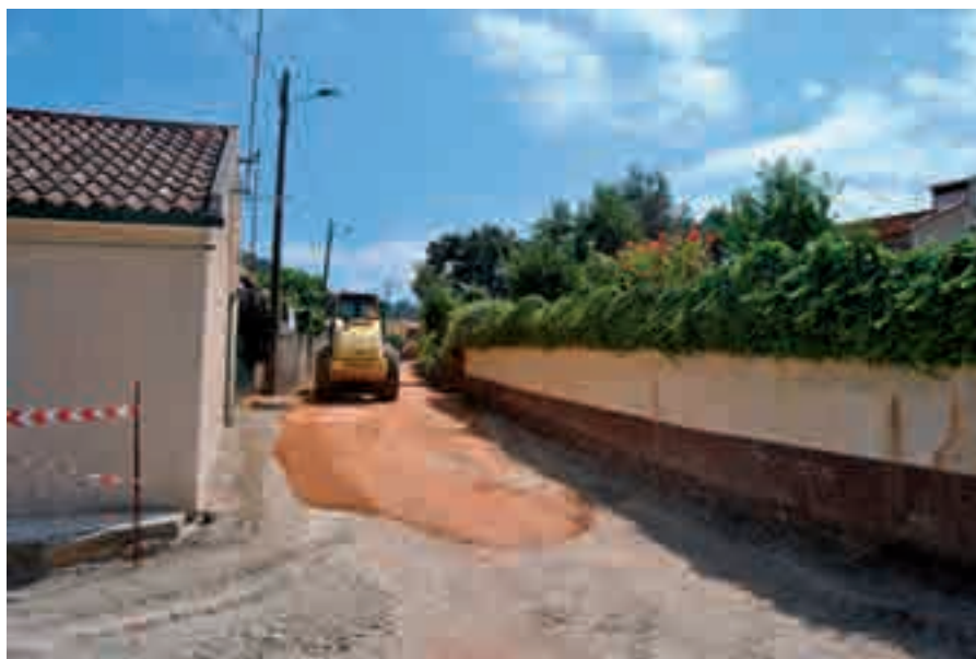
Pavimentação na Rua do Guincho (Chão de Couce) - 35.820€
