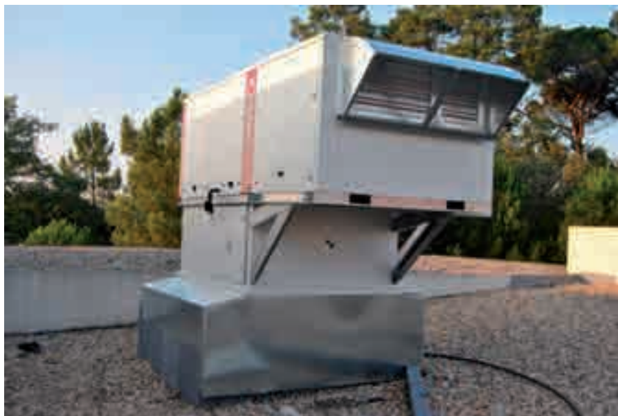
Beneficiação do Centro Cultural - Substituição da Unidade de Climatização AVAC 40.000€
