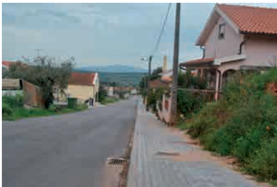
Rede de águas pluviais e passeios em Casal de Santo António (Avelar) - 36.200€
