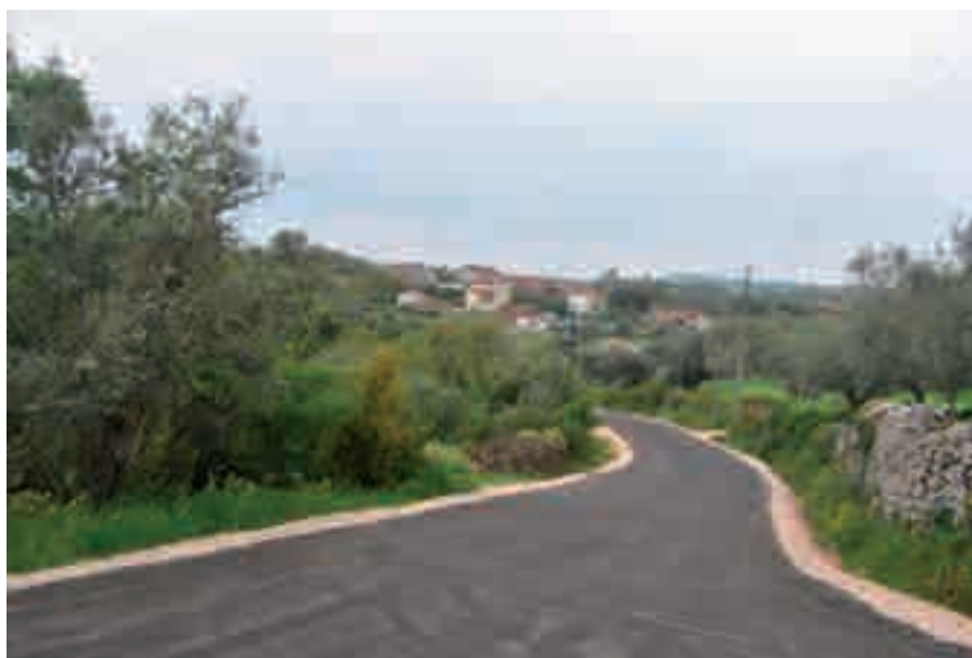
Pavimentação em Lagarteira de Cima ao Pião (Lagarteira) - 37.200€
