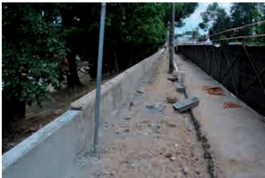
Construção de muros e passeios junto ao Campo da Mata (Ansião) - 30.000€
