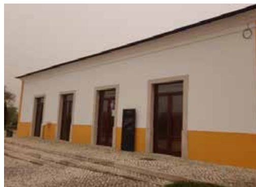
MUST-505 - Complexo Monumental de Santiago da Guarda: Conservação e Beneficiação 2023
