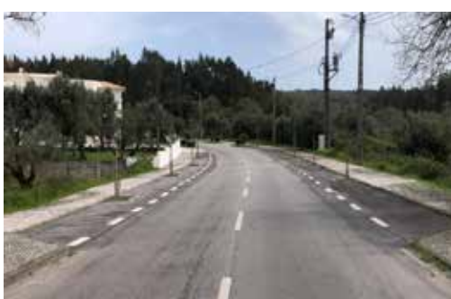
MUST- Sinalização Horizontal: 2023
