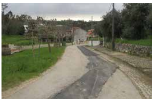
MUST- 481 - Pavimentações e Arranjos em Diversas Estradas, Caminhos 2022: Santiago da Guarda e Ansião.
