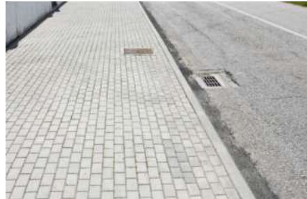
MUST-421 - Construção de Passeios na Rua de Coimbra - Avelar
