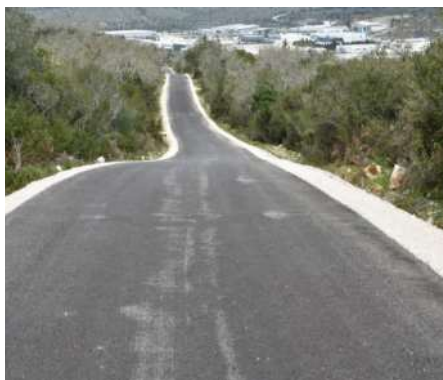
MUST-470 - Pavimentações Freguesia de Chão de Couce: 2022
