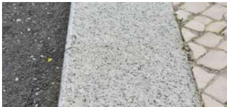
MUST-484 - Requalificação Urbana: Outras Intervenções / Conservação - Boleamento de Lancis.
