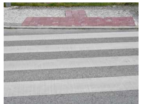
MUST-442 - Criação/Beneficiação da rede de percursos pedonais da Vila de Ansião: adaptação de passadeiras para pessoas com mobilidade reduzida.
