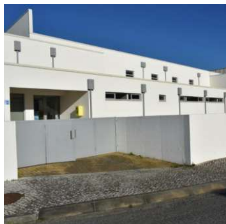
MUST-446 - Conservação e Beneficiação de Pavilhões desportivos: Pavilhão de Santiago da Guarda - 2021
