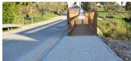
MUST-438 - Construção de Passeios na Rua Visconde Alfredo César Vieira - Santiago da Guarda
