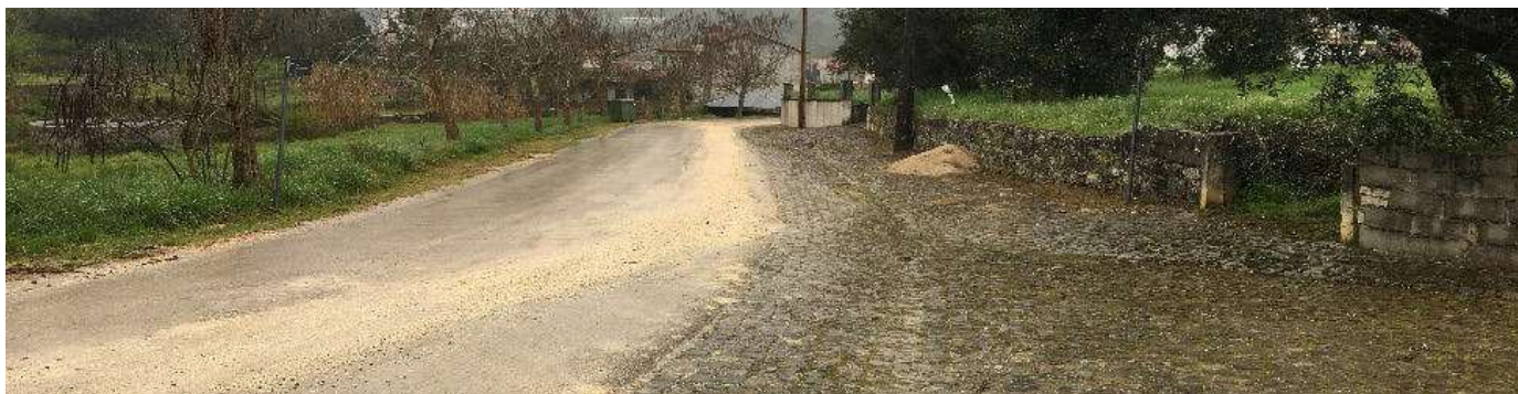
MUST-481 - Pavimentações e Arranjos em Diversas Estradas, Caminhos 2022: Santiago da Guarda e Ansião
