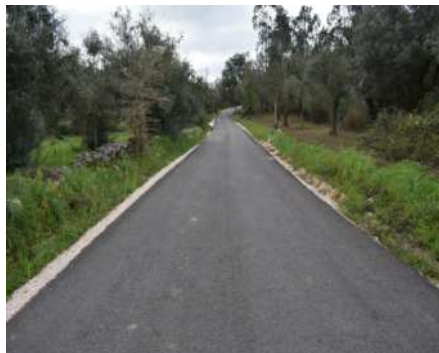
MUST-471 - Pavimentação Fonte Galega / Ribeira do Açor - Ansião
