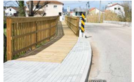
MUST-456 - Construção de Passeios na Rua da Serrada da Mata - Chão de Couce
