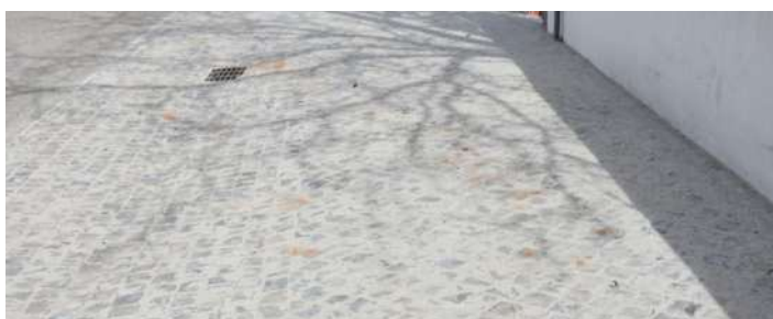
MUST-462 - Pavimentação em Calçada de Diversos Arruamentos: 2021/2022
