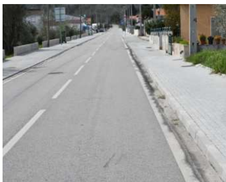
MUST-433 - Construção de Passeios na Rua da Espinheira - Chão de Couce
