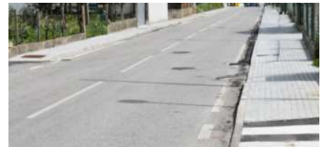
MUST-434 - Construção de Passeios na Rua do Pontão - Chão de Couce
