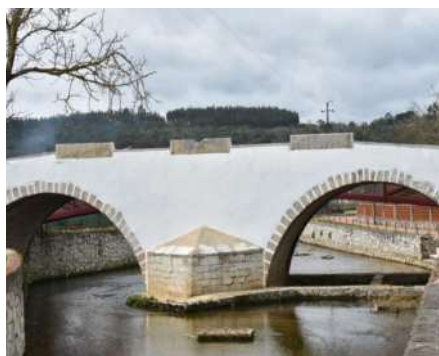
MUST-477 - Parque Verde do Nabão / Conservação e Beneficiação: Pintura Ponte da Cal
