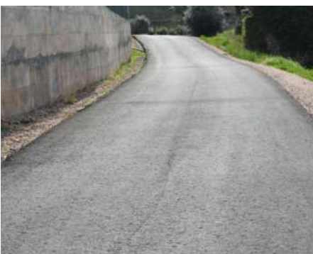
MUST-469 - Pavimentações freguesia de Santiago da Guarda: 2022
