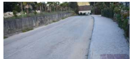
MUST-436 - Construção de Passeios nas Ruas das Vinhas - Santiago da Guarda
