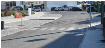
MUST-437 - Construção de Passeios na Ligação de Santiago à Várzea - Santiago da Guarda
