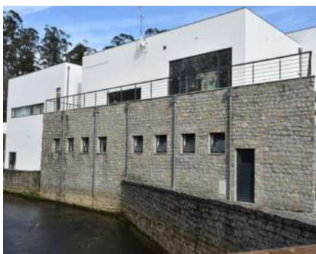
MUST-467 - Conservação e Beneficiação de Outros Edifícios: Edifício Nascente do Nabão 2022
