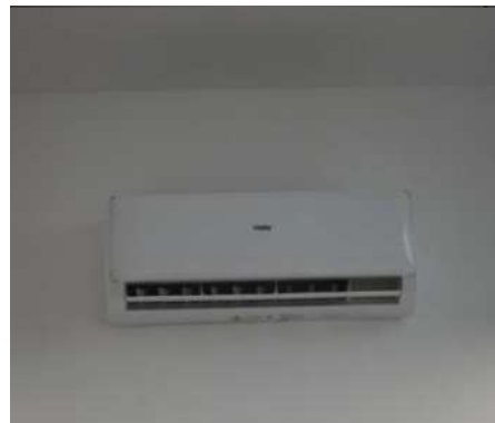
MUST-475 - Loja de Cidadão de Ansião: Ampliação Sistema AVAC 1º Andar
