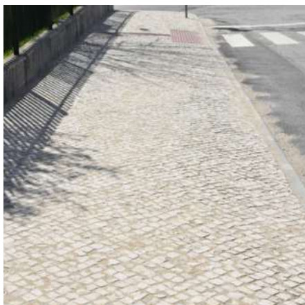
MUST-432 - Construção de Passeios na Rua Dr. Rosa Falcão - Avelar
