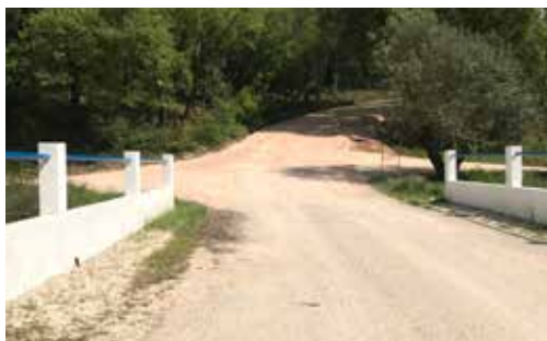
Pavimentação Rua São Sebastião - Albarrol
