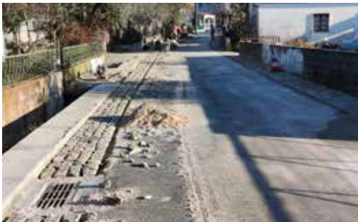
Calcetamento bermas e valetas, em Netos
