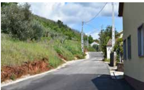
Pavimentação Betuminosa Rua Mata Furadouro - Chão de Couce FOTO 12045
