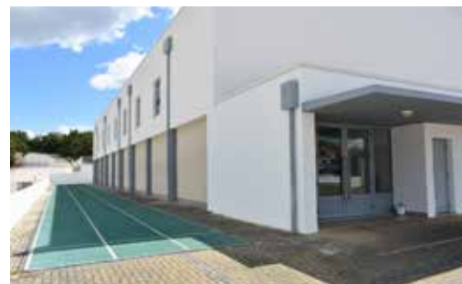
Conservação e Beneficiação do Pavilhão Desportivo de Santiago da Guarda
