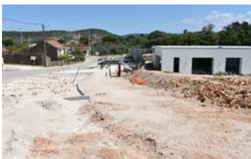
Loteamento Municipal de Santiago da Guarda
