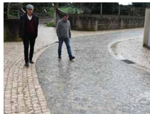
Pavimentação de Arruamentos em Aljazeera - Alvorge
