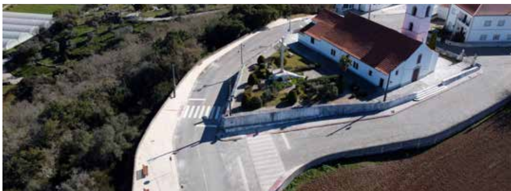
Construção de Passeios na Circular Norte de Alvorge
