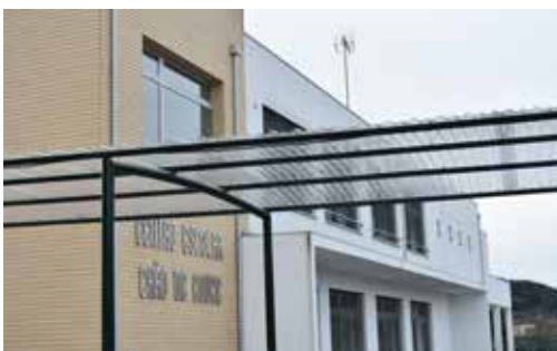
Conservação e Beneficiação de Instalações no Centro Escolar de Chão de Couce
