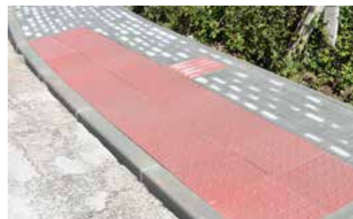
Construção de Passeios na Rua de Coimbra - Avelar
