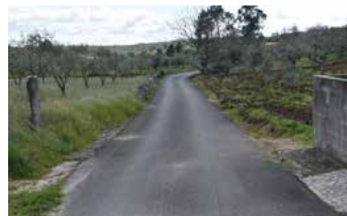
Pavimentação da Rua dos Tralhões, em Alvorge
