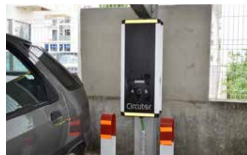
Aquisição e Instalação de Carregadores Elétricos: Centro de Saúde
