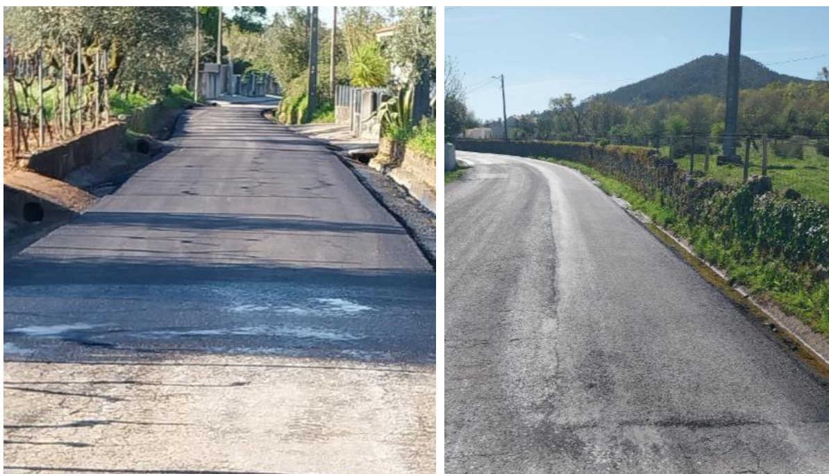
MUST-557 | Pavimentações e Arranjos em Diversas Estradas, Caminhos: 2025
