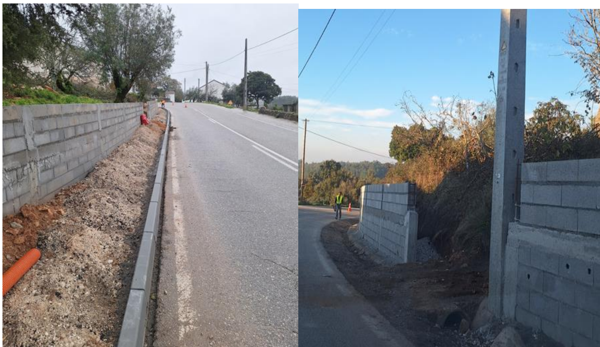
MUST-553| Construção de Passeios na Estrada dos Peregrinos - Pousaflores
