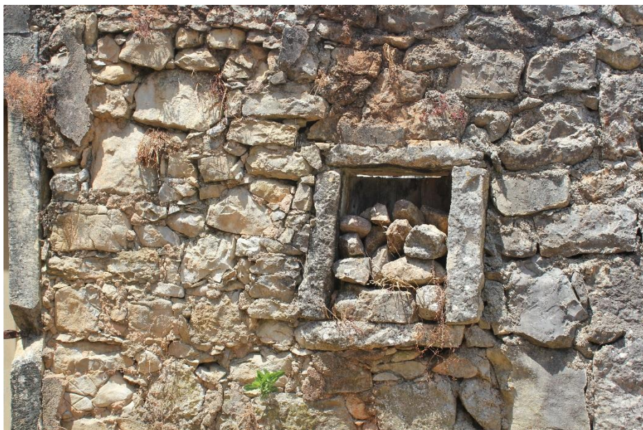
Construção com pedra calcária na ARU de Granja
