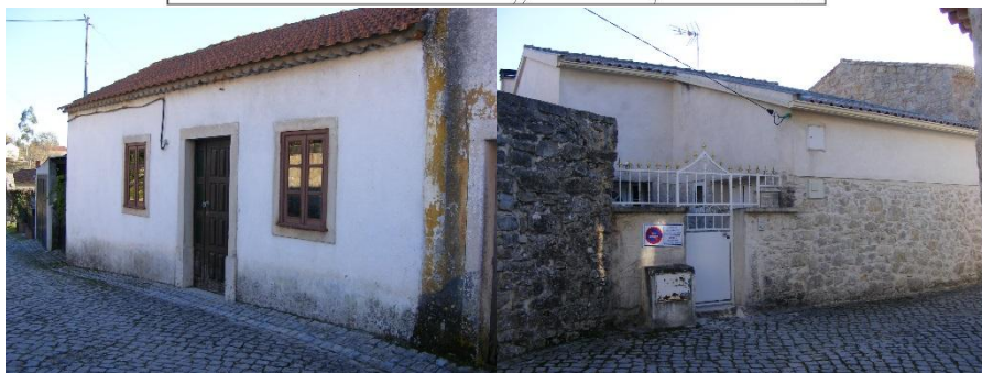
Edificado com dissonâncias visuais na ARU de Granja
