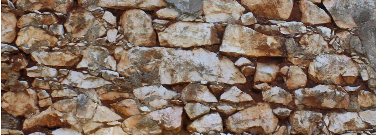
Figura 10. Utilização da argila como argamassa no assentamento de alvenaria de pedra
