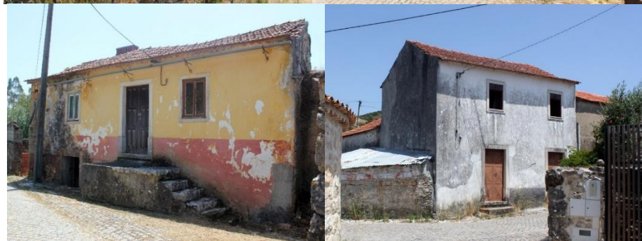
Construções de origem vernacular na ARU de Granja – Rua da Senhora da Orada (exemplos)
