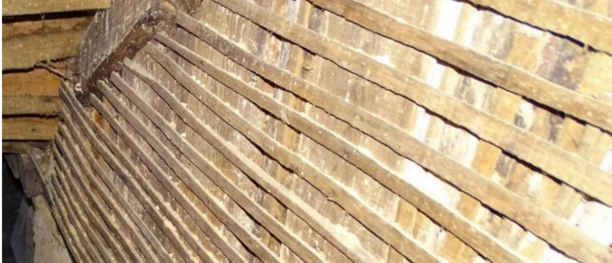
Figura 13. Parede divisória em tabique
