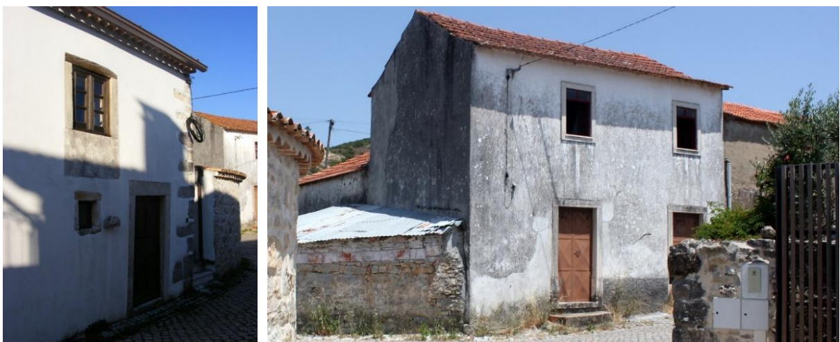
Figura 16. Casas de dois pisos na Rua da Senhora da Orada
