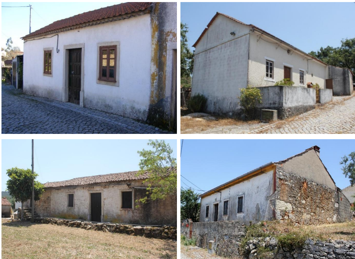
Figura 14. Casas térreas na ARU de Granja
