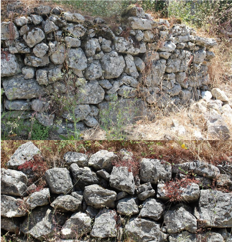
Muros de pedra seca/solta na ARU de Granja
