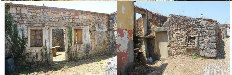
Conjunto edificado alvo de reabilitação para fins turísticos na ARU de Granja
